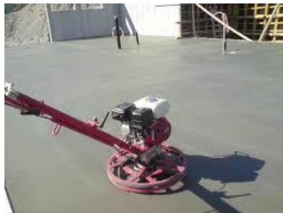
Stålglatting av betonggulv
