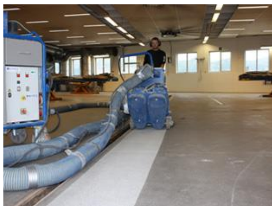
Blastring av stålglattet betonggulv
